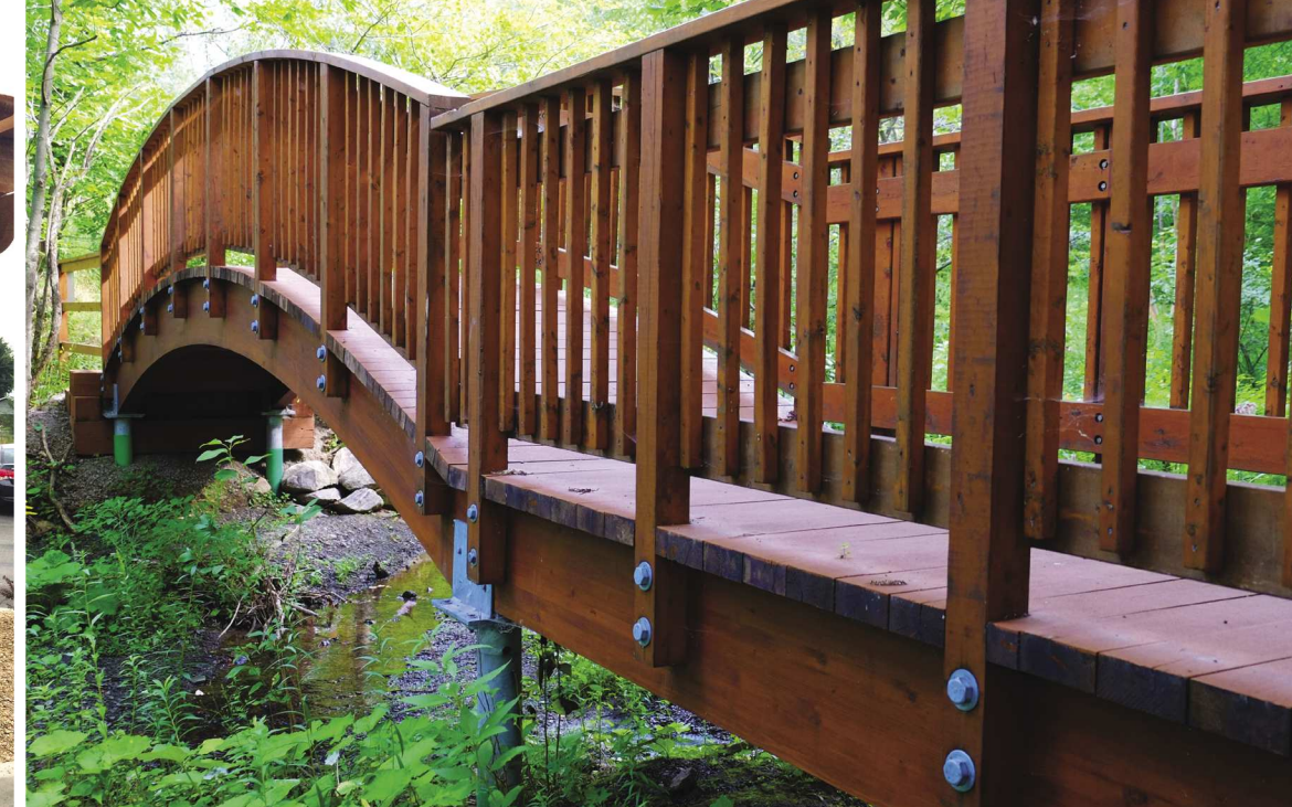
PONTS / PASSERELLES / SENTIERS
